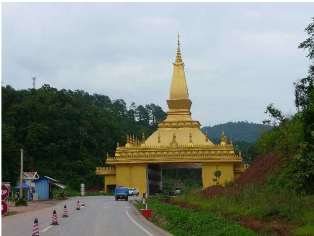
【入出国管理事務所が移転予定の建築物】
