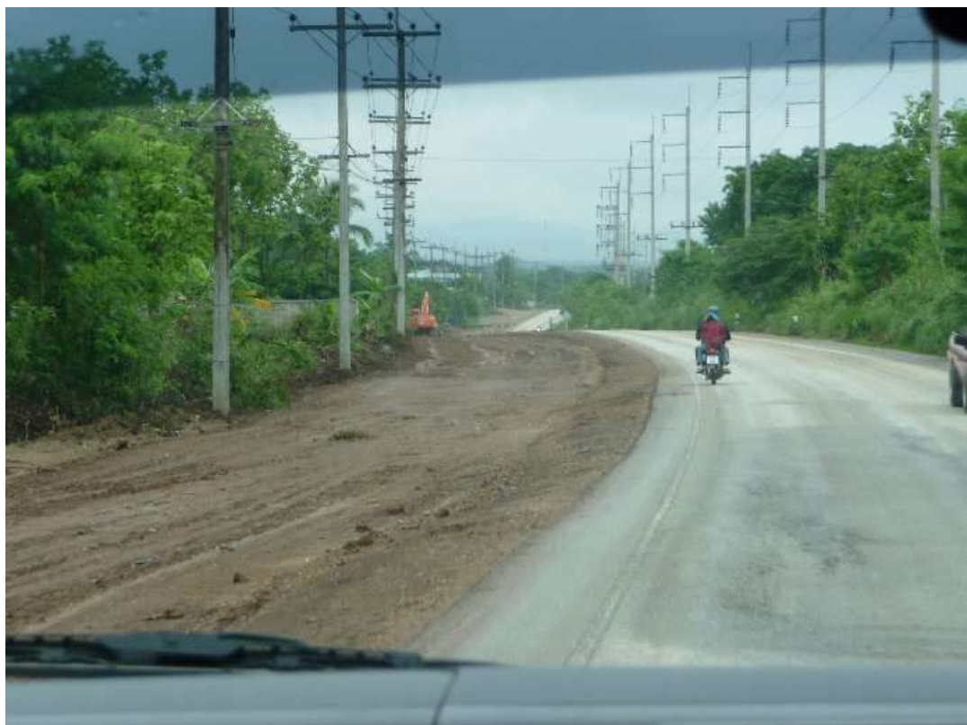
【1020号線（拡張工事区間）】
