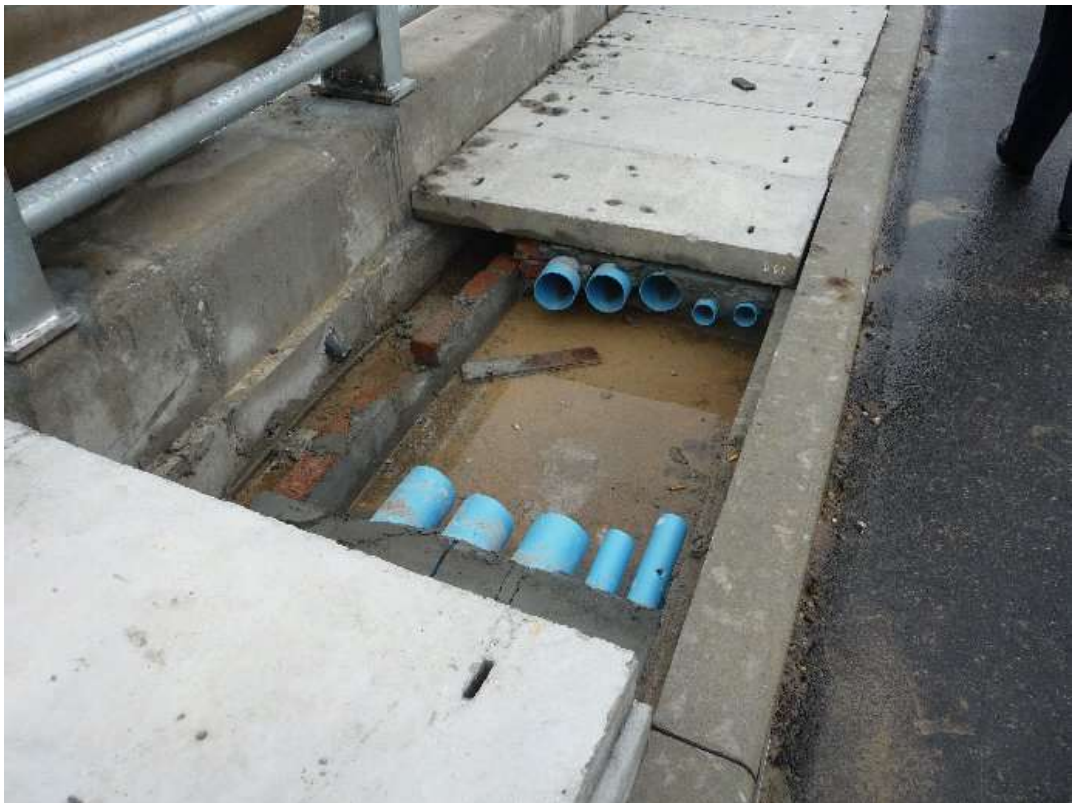
【配管工事の様子】
