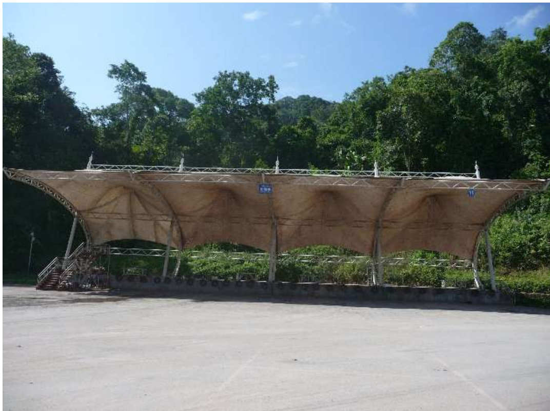
【貨物検査スペース】
