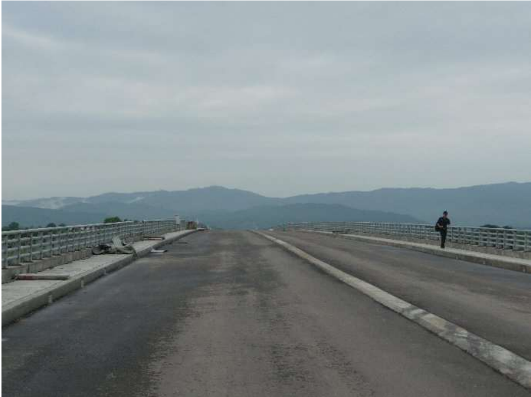
【タイラオス第4友好橋工事の現況】
