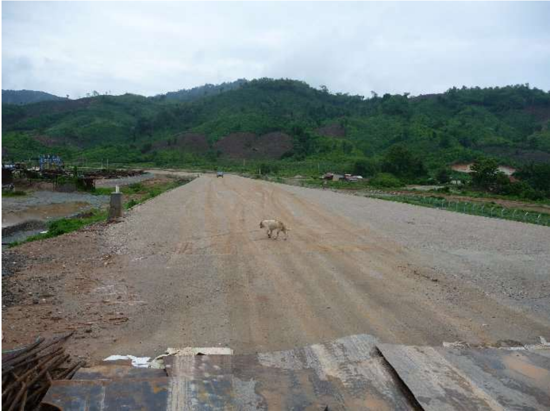
【タイーラオス第4友好橋に至る取り付け道路（ラオス側）】
