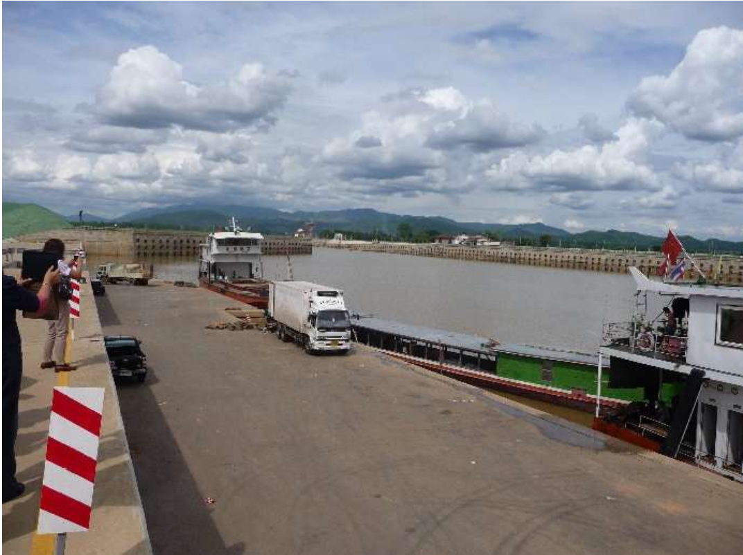
【雨季と乾季でメコン川の水量が大きく変わるため、岸壁は2段構えとなっている】
