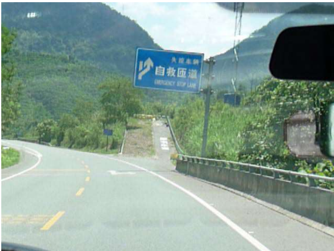
【下り坂途中に設置された緊急待避レーン】
