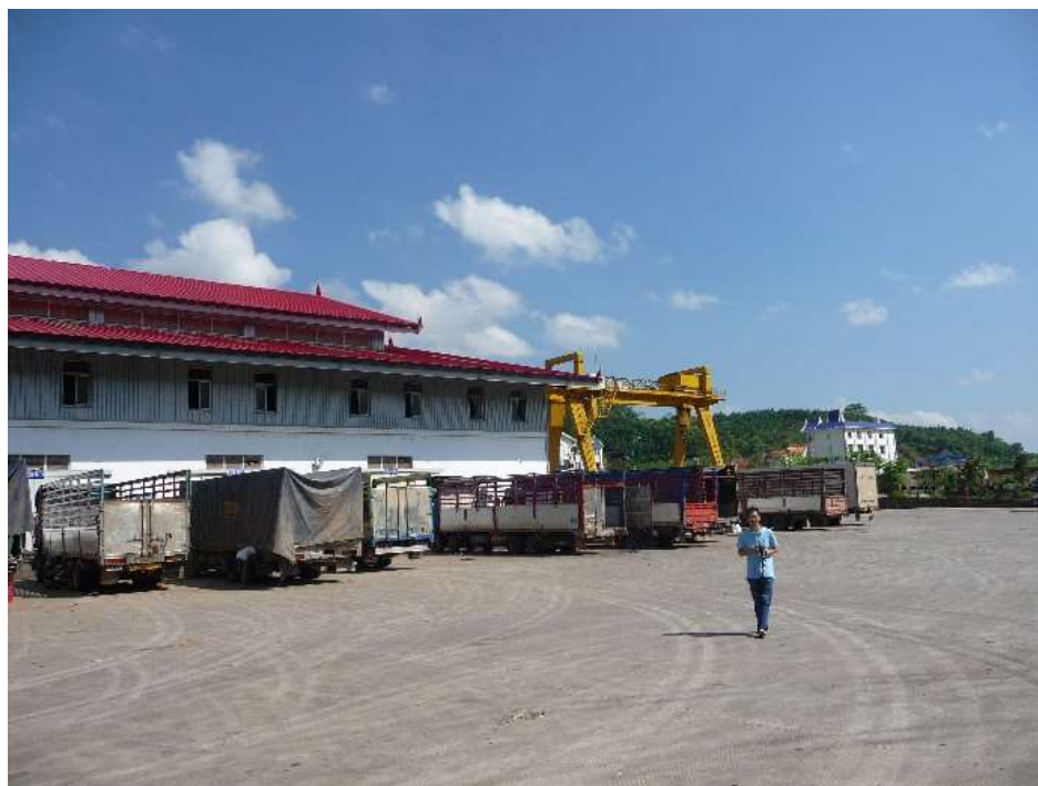
【高床式物流倉庫 奥は重量物クレーン】
