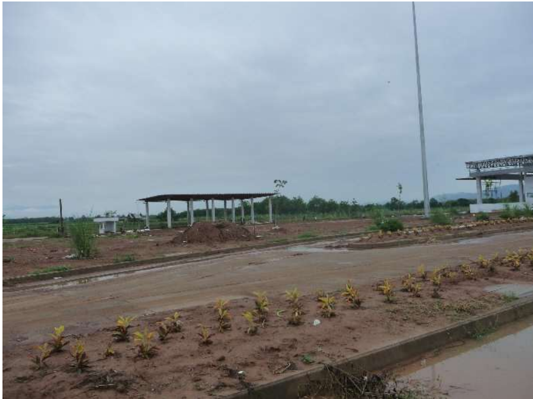
【タイ側で建設中の検査場（敷地は未舗装）】
