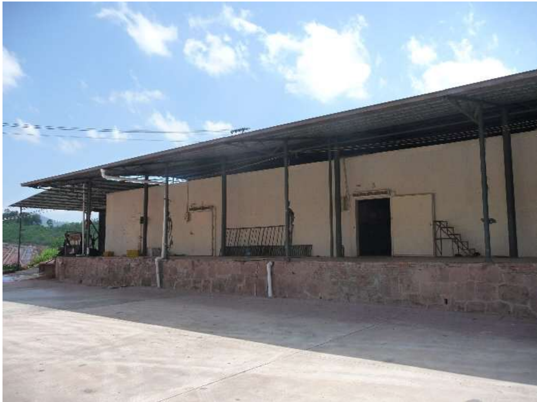
【冷凍冷蔵倉庫 空のスペースは扉が開放されていた】
