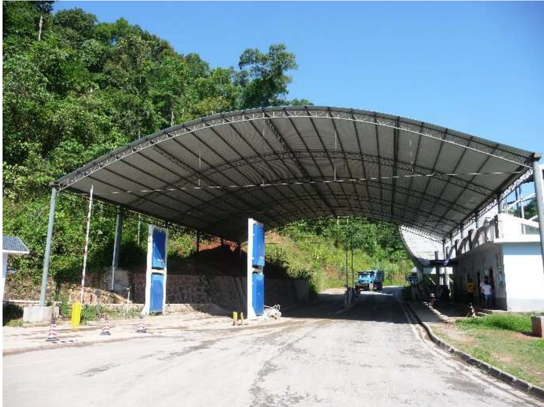
【貨物検査場ゲート X線車両検査システムが設置されている】
