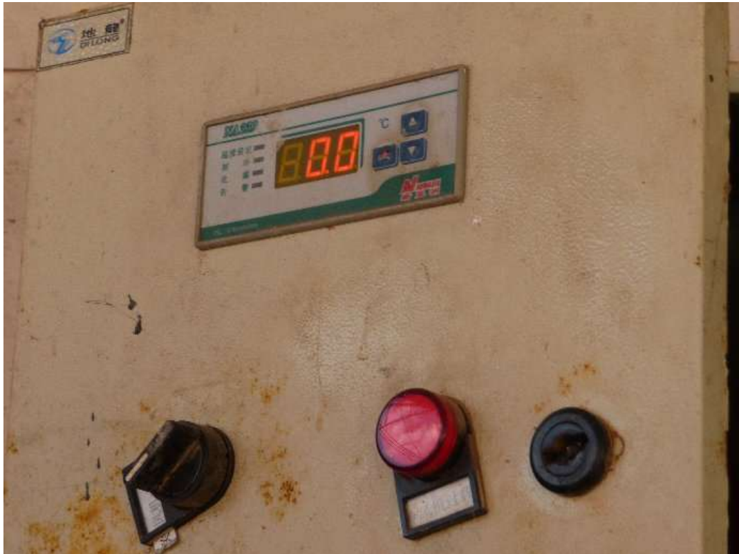
【庫内温度を設定する操作盤 この日は0℃に設定されていた】
