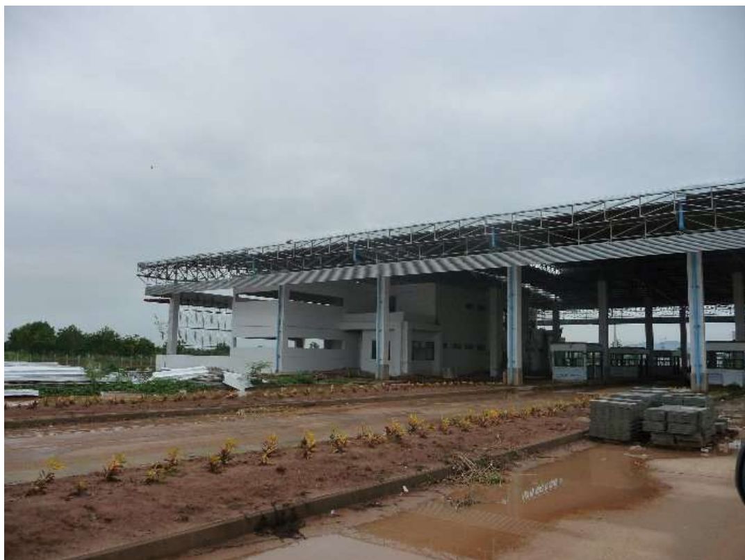
【タイ側入出国ゲート兼税関施設（屋根にはまだ隙間が見える）】
