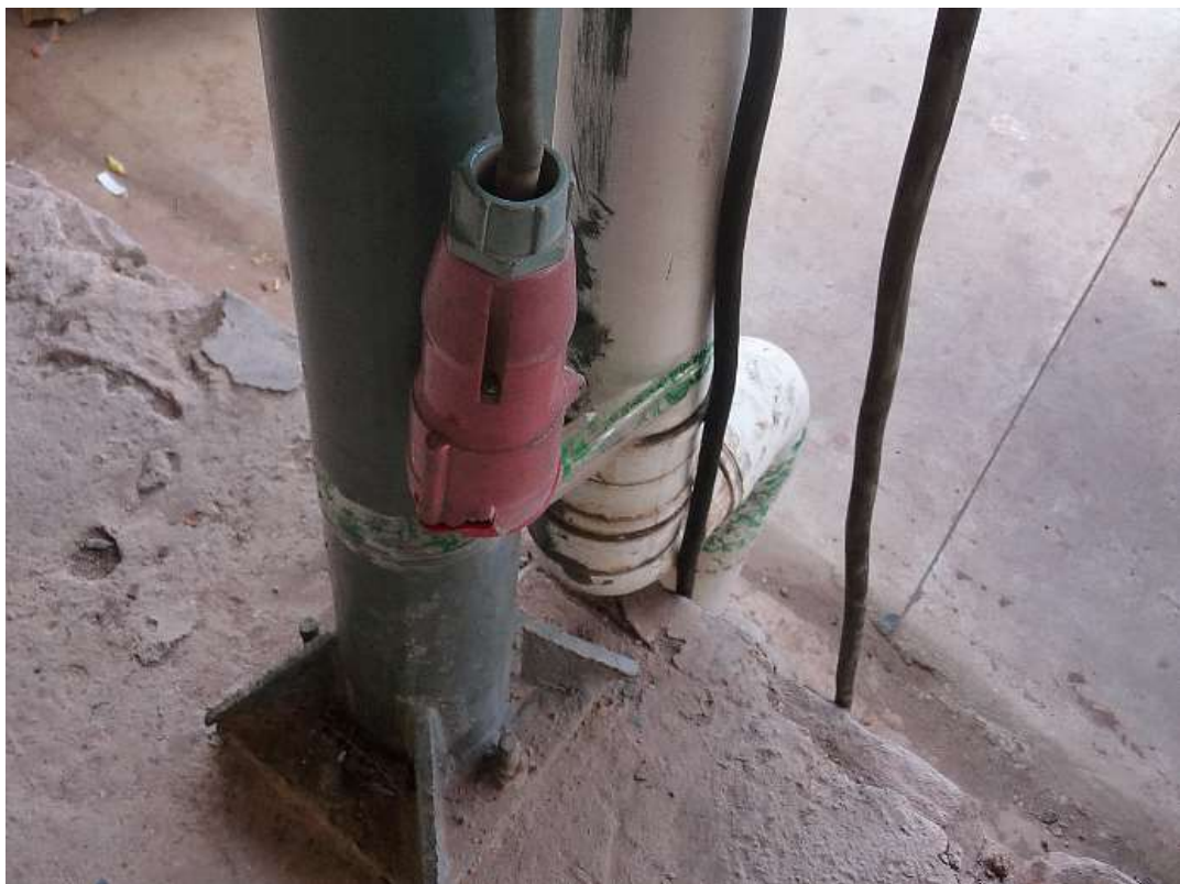
【柱部分にはリーファーコンテナ用電源がぶら下がっている】
