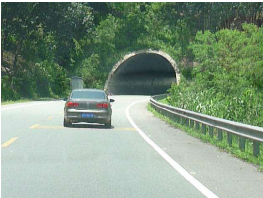
【こうしたトンネルが区間中の随所に整備されている】
